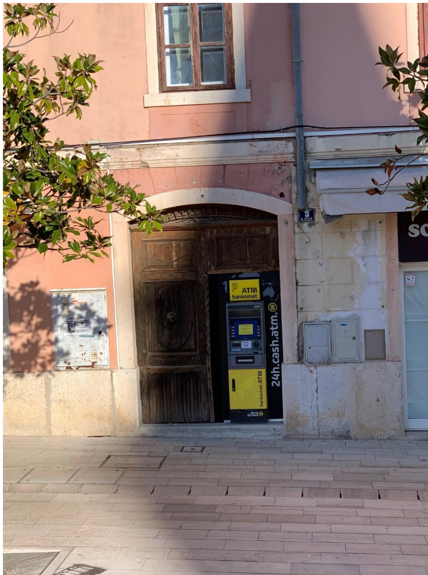
Totalno neprimjereno postavljanje bankomata u povijesnoj jezgri grada
